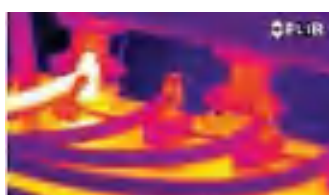
FLIR thermal image
